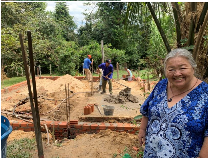
Início da obra dos banheiros externos
