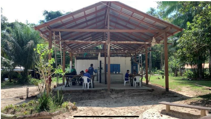
Reforma do telhado da cozinha e refeitório
